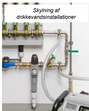
Desinficering af drikkevandsinstallationer
